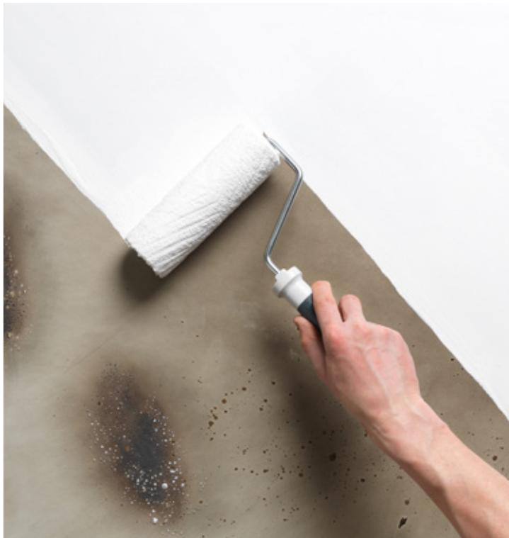
**Cover Stain® ist ein Fleckenblocker, Isolator und eine Haftgrundierung mit ausgezeichneter Deckkraft für den Innen- und Außenbereich, der nach nur 30 Minuten staubtrocken ist und nach zwei Stunden überlackiert werden kann. Diese schnell trocknende, universelle Grundierung auf Lösungsmittelbasis haftet perfekt auf schwierigen Untergründen und ist unsere beste Fleckenschutzgrundierung für den Außenbereich.**
